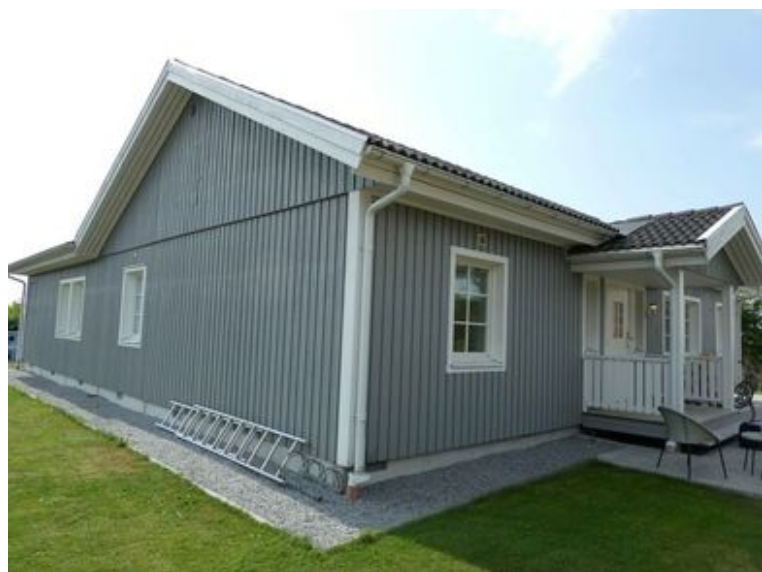
Fasader och fönster
