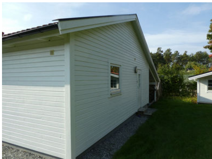
Fasader och fönster
